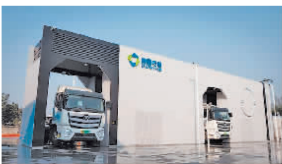
协鑫电港位于成都的首座自主研发的双通道重卡换电港。
