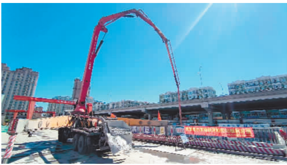
地铁3号线西北环河松街站施工现场。
