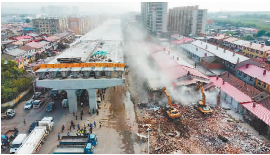
依法拆除建筑物现场。本报记者 孙岩摄 备,对征收范围内8处剩余房屋实施了依法拆除,当日实现建筑物、构筑物拆除面积近3000平方米,为机场第二通道项目主桥建设扫清障碍。 下一步,道里区委、区政府将继续发挥
