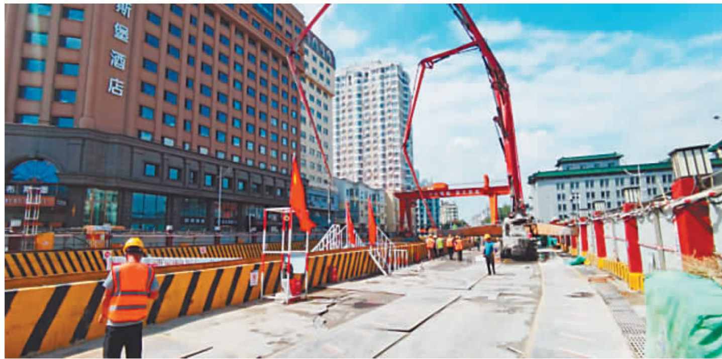
地铁3号线友谊宫站施工现场。
