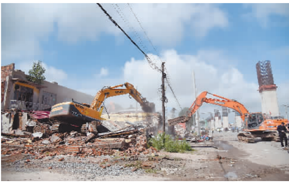
执法人员进行拆违作业。
