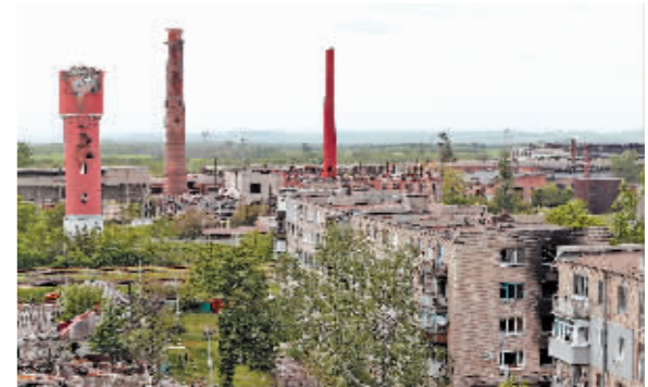
图为5月26日在卢甘斯克波帕斯纳亚拍摄的被损坏的建筑。新华社发
