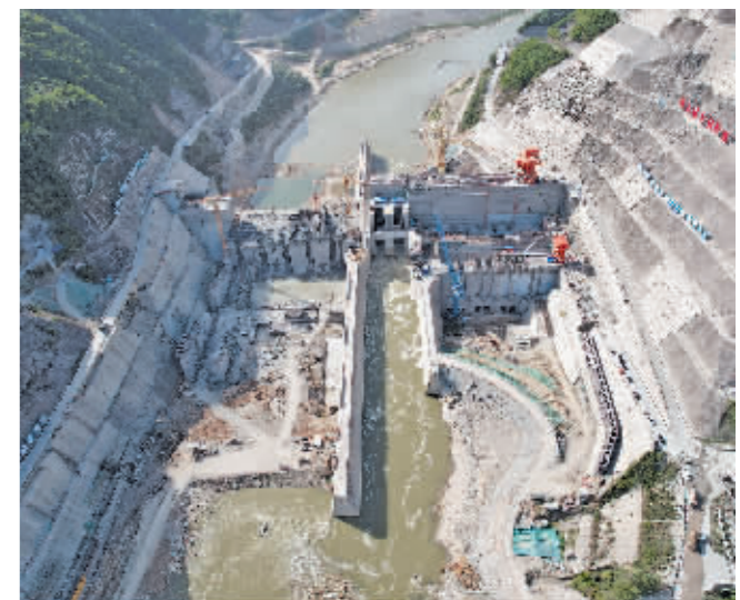
图为建设中的黄金峡水利枢纽工程。 新华社发
