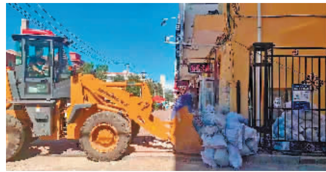
清除小区内乱摆乱放杂物。
