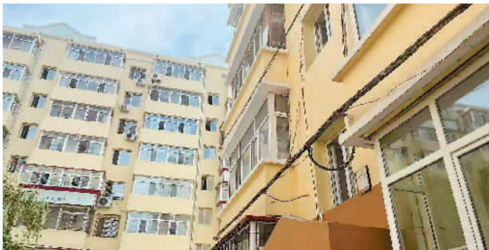
改造后的老旧小区焕然一新。
