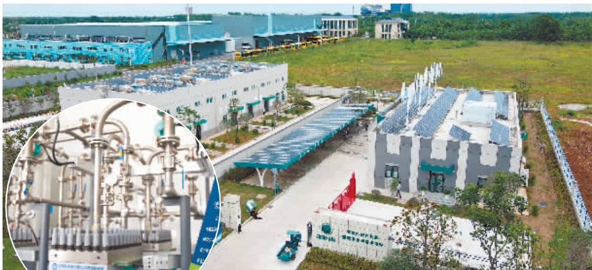
示范站外景。示范站内的兆瓦级电解水制氢系统。
