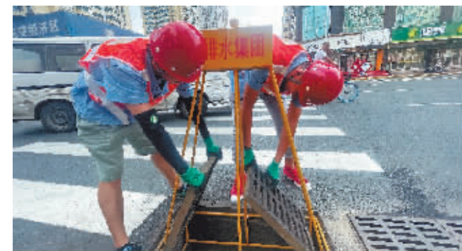
工作人员检查排水口。
