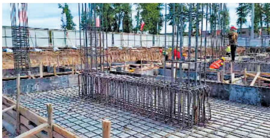
项目建设现场。
