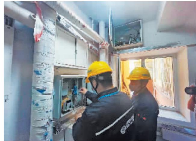
工作人员检修网络线路。本报记者 孙岩摄
