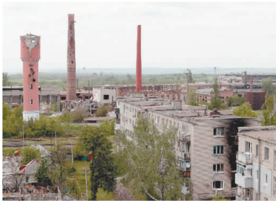
这是5月26日在卢甘斯克波帕斯纳亚拍摄的被损坏的建筑。
