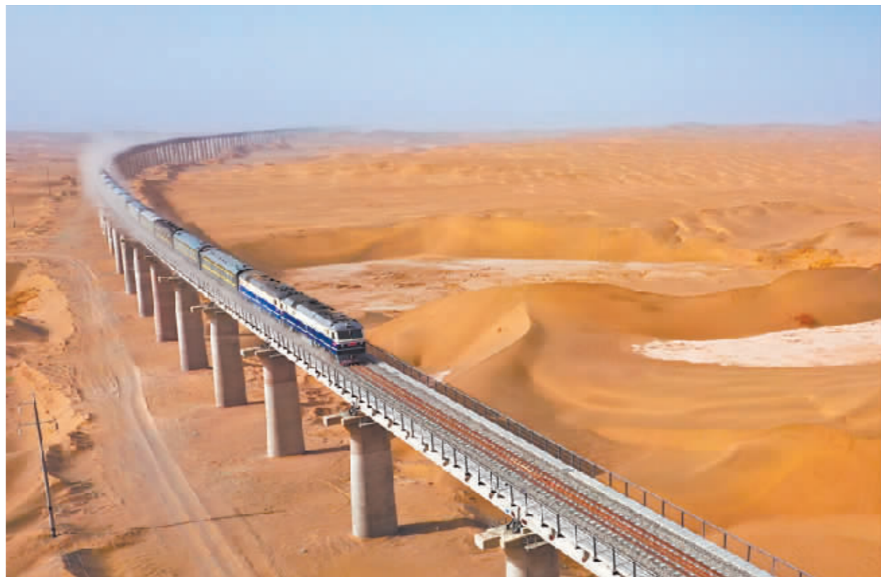
图为动态检测车驶过若羌雅特大桥。
