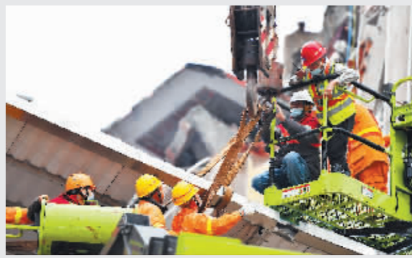
救援人员对倒塌房屋进行切割吊装作业。
