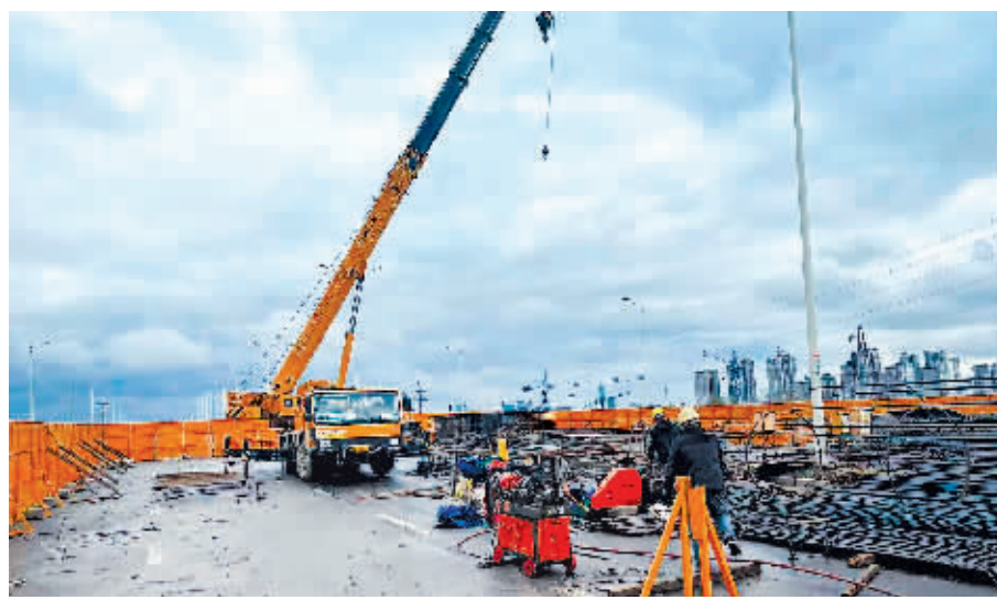
东三环快速路项目施工现场。
