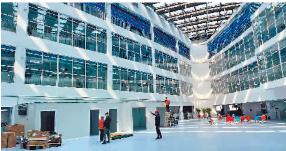
哈尔滨市应急方舱医院竣工。
