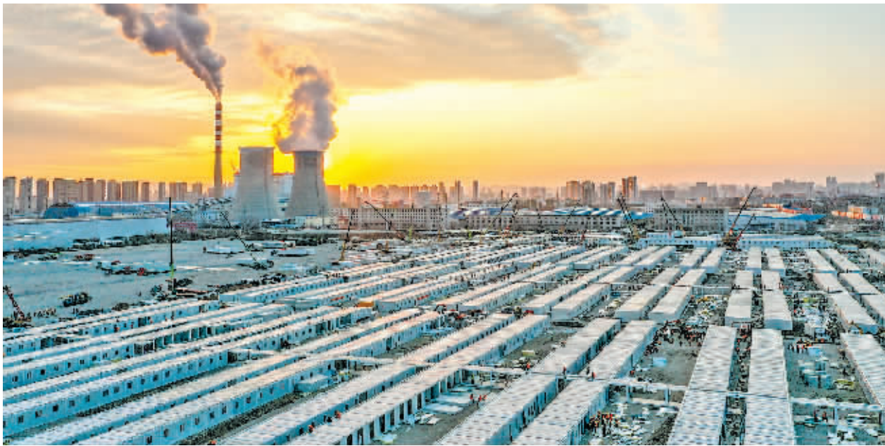
3月20日傍晚拍摄的吉林市高新南区隔离方舱建设现场。
