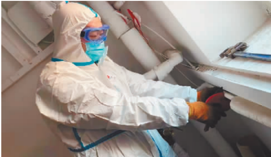
工作人员维修供热管线。
