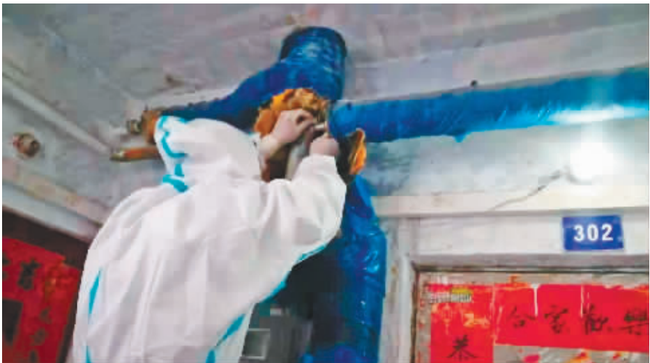
供暖公司员工上门维修管线。
