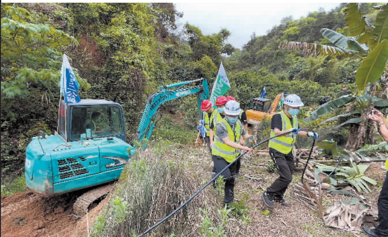
3月22日,在广西藤县埌南镇莫埌村,挖掘机开挖进入东航MU5735客机坠毁事故现场的通道,为后续工作铺平道路(手机照片)。 新华社发
