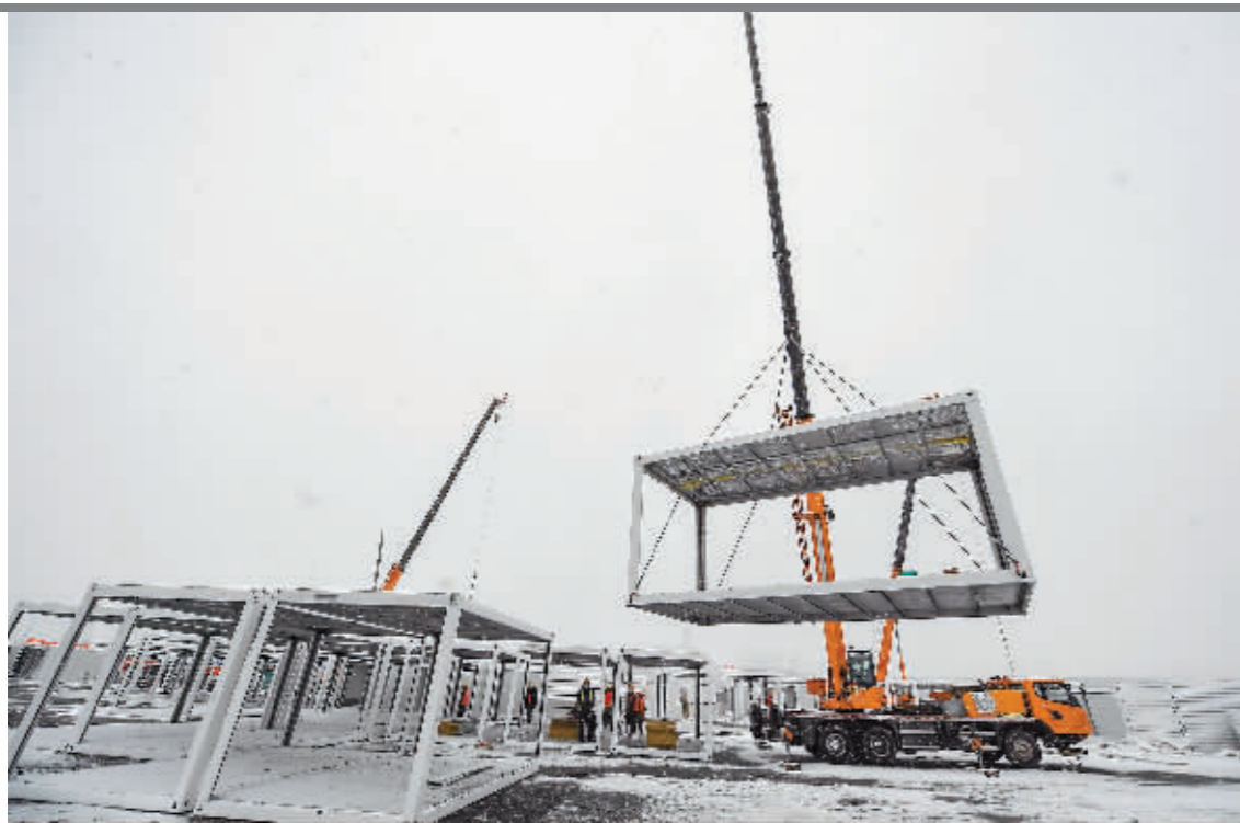
在吉林市高新南区隔离方舱项目施工现场,工人吊装隔离方舱箱体。
