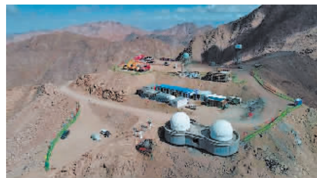
冷湖天文观测基地中的天文望远镜项目建设现场。(受访者供图)
