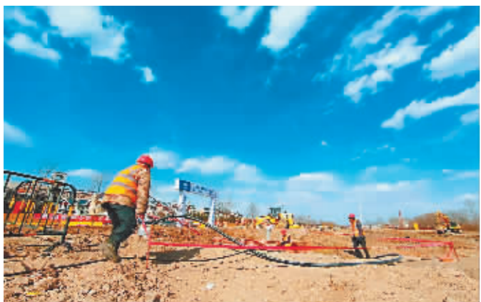
延寿新建供水厂施工正酣
