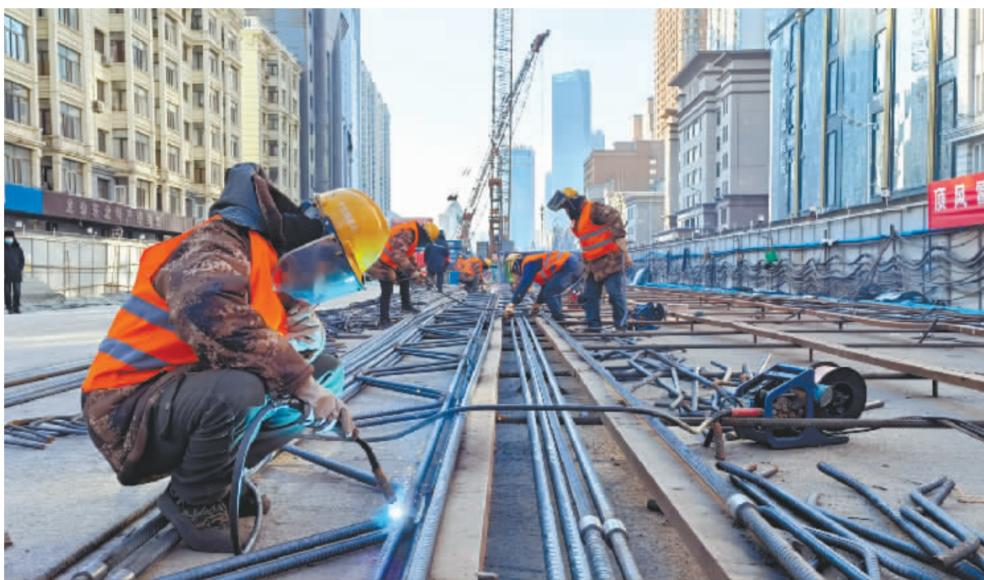
右图:施工人員紧张有序作业。
