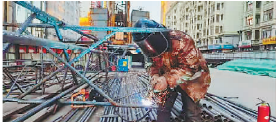
张作业。上海街站施工现场,工人正在紧
