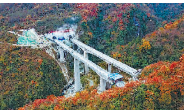
成兰铁路跃龙门隧道兰州方向洞口。 新华社发
