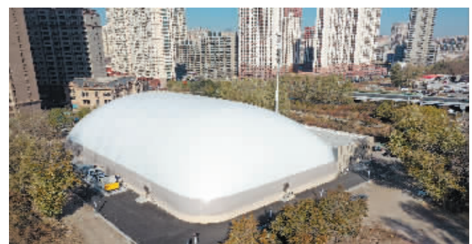
道里区气膜式冰上运动中心建设完成。
