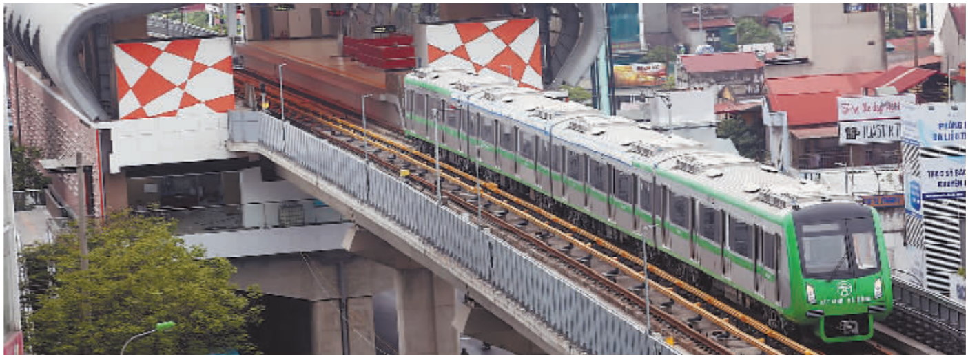
11月6日,列车在越南首都河内吉灵—河东轻轨线上行驶。中企承建的越南首条城市轨道交通项目交接仪式当日在河内举行,标志着该项目投入运行。
