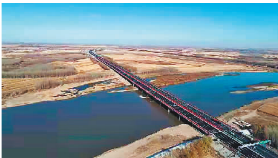
京哈高速拉林河(吉黑省界)至哈尔滨段改扩建项目完工通车。
