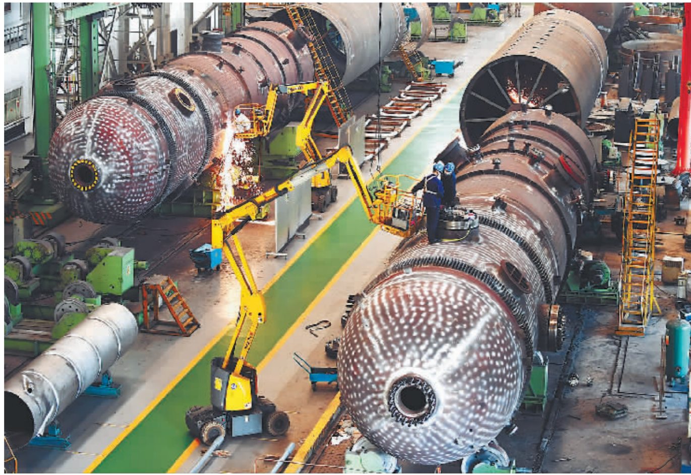
哈尔滨锅炉厂有限公司内，世界日投煤量最大气化炉正在这里总装。
