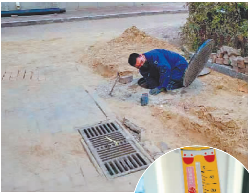
工作人员对供热管线进行排查、检修。
