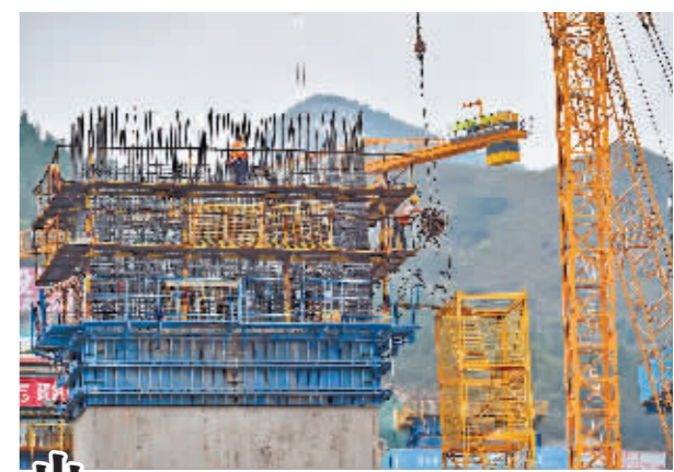
10月3日,建筑工人在山东省济潍高速公路青州段一座大桥建设现场施工。 新华社发
