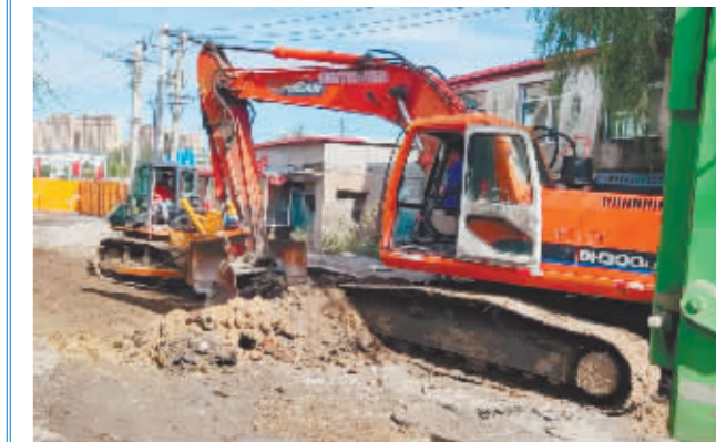
道路施工现场。
