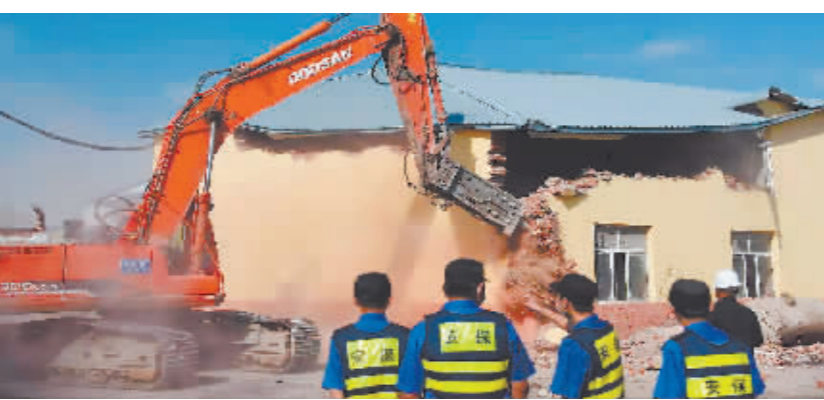
拆违现场。本报记者 孙岩摄
