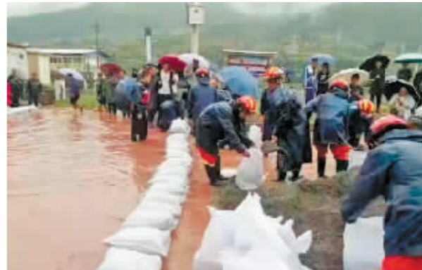
喜德救援力量正堆沙袋改变水流方向,引导洪水流入东沟河。
