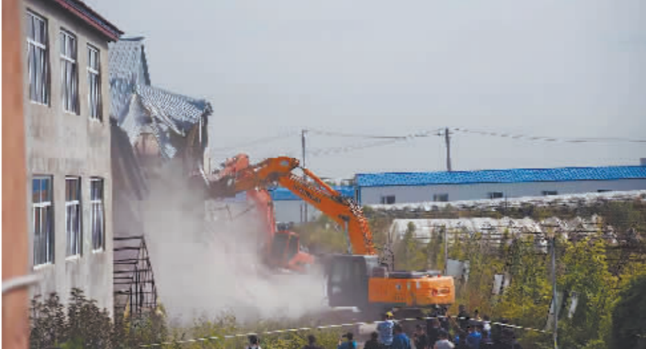
拆违现场。本报记者 孙岩摄
