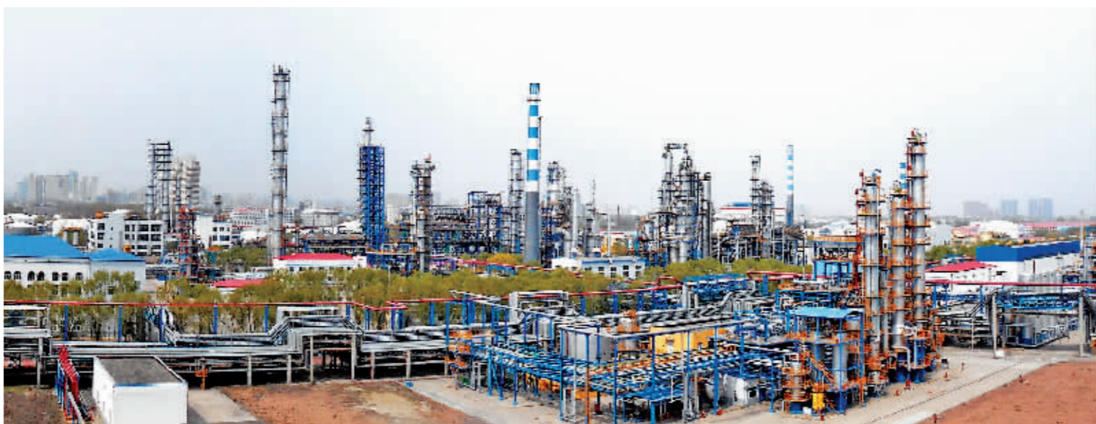
哈石化循环冷却水余热回收能效提升项目正在紧张施工中。
