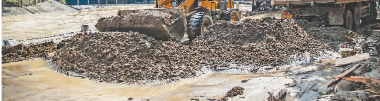
8月28日以来,重庆市巫溪县遭遇连续强降雨天气。30日,洪水退去后,当地组织人员对受灾严重的乡镇展开道路清淤、设施抢修和隐患排查等灾后工作,全力保障群众灾后生产生活。图为8月30日,在重庆市巫溪县宁河街道漫滩路,工作人员清理洪水退去后留下的泥沙。 新华社发
