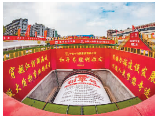
“和平号”盾构机始发。 中铁十四局供图
