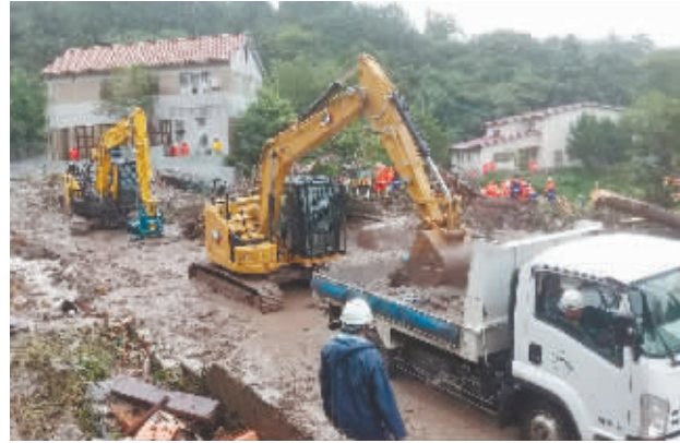
8月15日,消防员在日本九州地区长崎县的泥石流现场参与救援。
