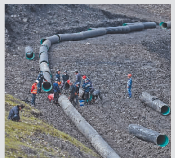
16日,救援人员在救援现场铺设排水管道。
